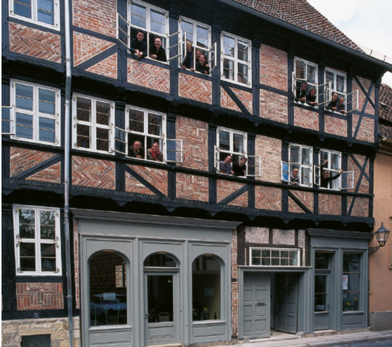
Wohn- und Seminarhaus der Jugendbauhütte Quedlinburg
